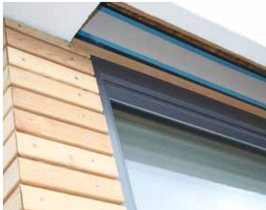
Rollladen- und Raffstoreddämmung
