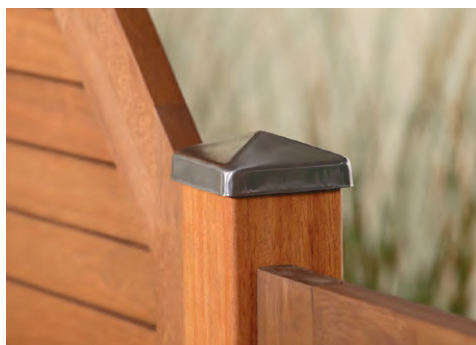
Konstruktiver Holzschutz: Schützen Sie die schichtverleimten Hartholzpfeosten zwingend mit Kappen aus Edelstahl (1602).
