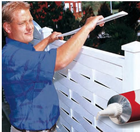
Kleber (3) zur Befestigung der Aufsatzleisten (2) und Kappen.
