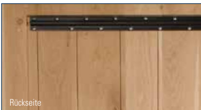
Rückseite Stahlprofil & Entlastungsrillen
