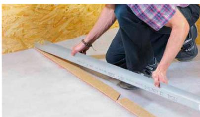
Boden- und deckenseitig werden handelsübliche UW-Blechprofile befestigt. Der STEICOsoundstrip Akustik-Dämmstreifen dient zur Schallentkopplung.
