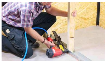
Die auf Länge geschnittenen STEICO LVL Stiele werden in die Profile eingestellt und lagesichert.
